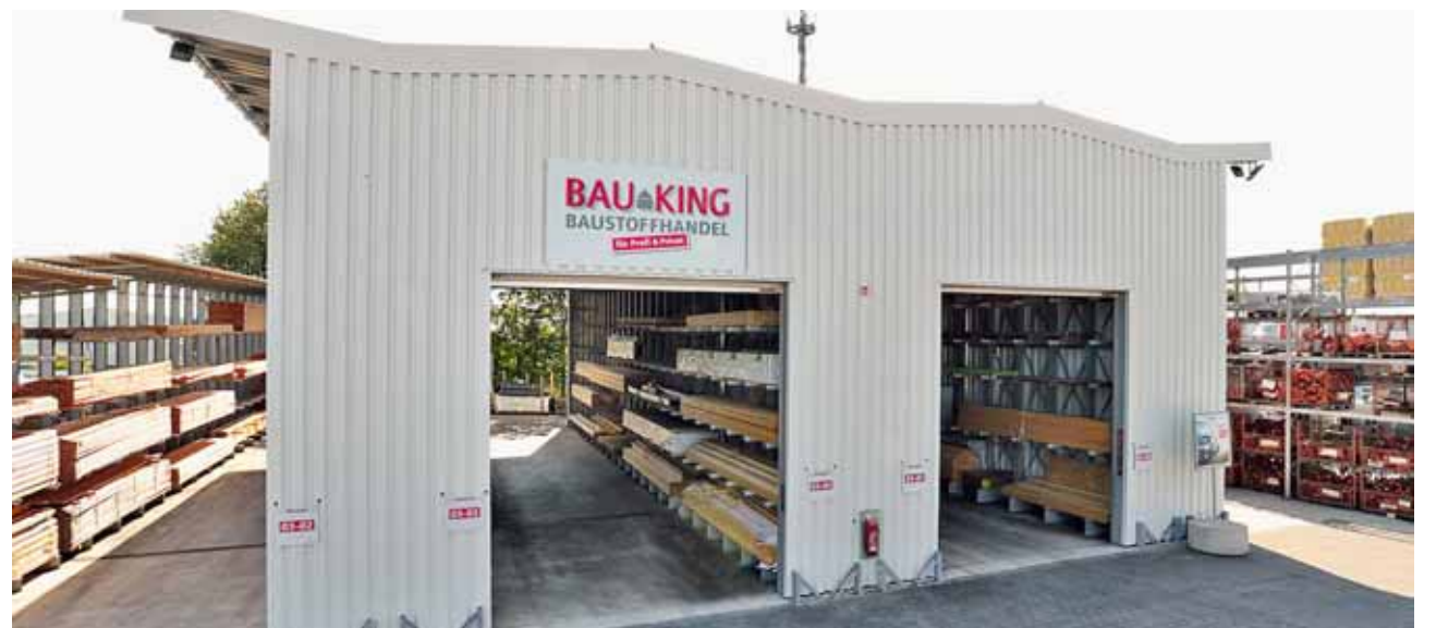
In der neuen, aus Kragarmregalen aufgebauten Regalhalle finden die Kunden des Baustoffhändlers Bauking am Standort Lorup jetzt alle Holzwaren zentral an einem Ort. Foto: Ohra
